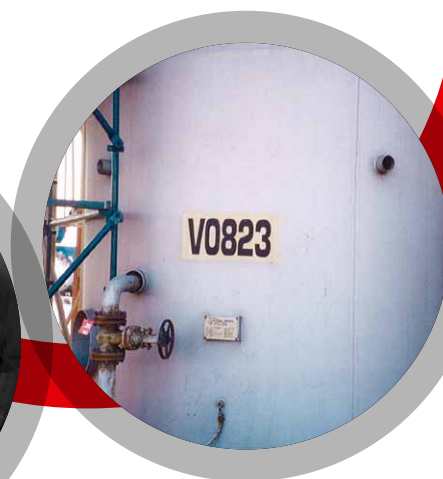
Tanques estabilizadores de líquidos de venteo
