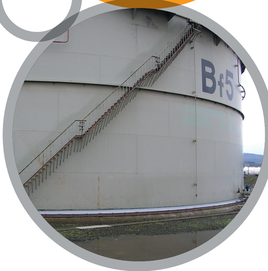
Réservoirs de stockage de produits chimiques
