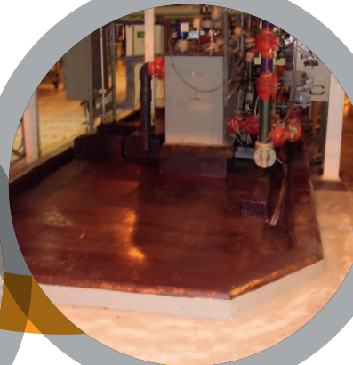
化学物储存区
