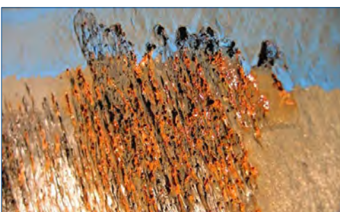
Bild 1: Kavitationsschäden an Stützschaufeln
