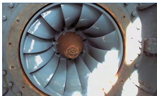
Repariertes Laufrad installiert und betriebsfähig
