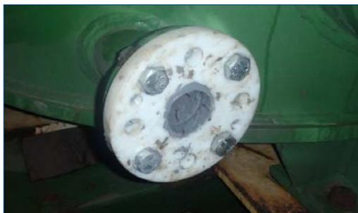
Molde posicionado com material Belzona
