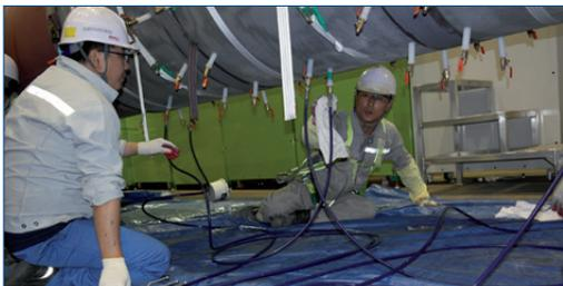
Injection de Belzona 1321
