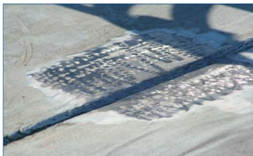
Oberfläche für den Belzona-Auftrag vorbereitet
