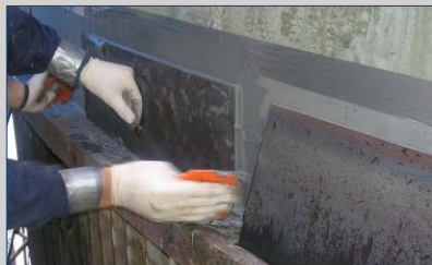
Reparatur von Löchern in der Wand
