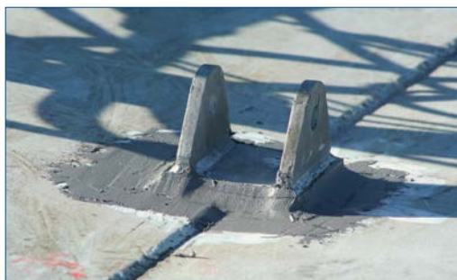
Mit Belzona 1111 verklebte Halterung
