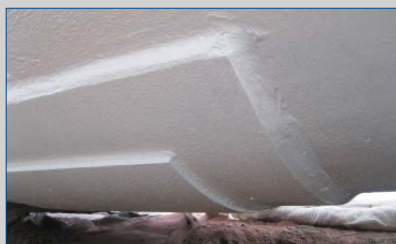
Verkleben von Verschleißblechen an einer Rohrleitung
