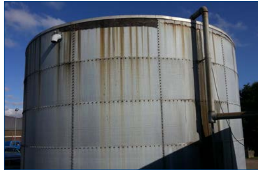
Korrodierte Tank
