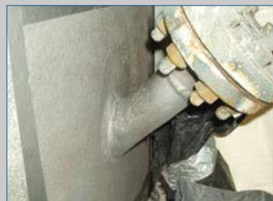
Korrodierte Stützen
